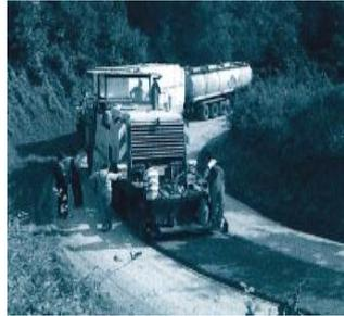
**Detalle:** extendedora de productos bituminosos, cemento...
