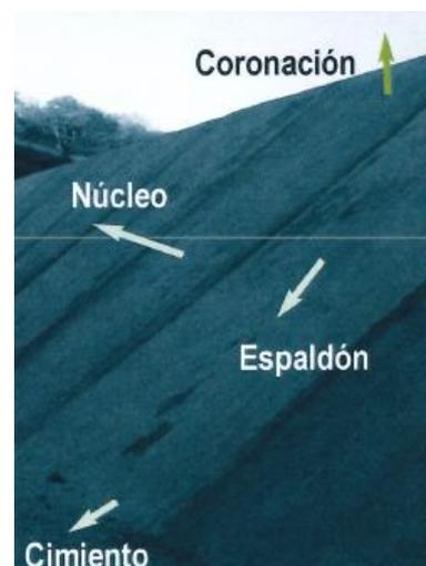
Detalle: Partes de un relleno tipo terraplén
